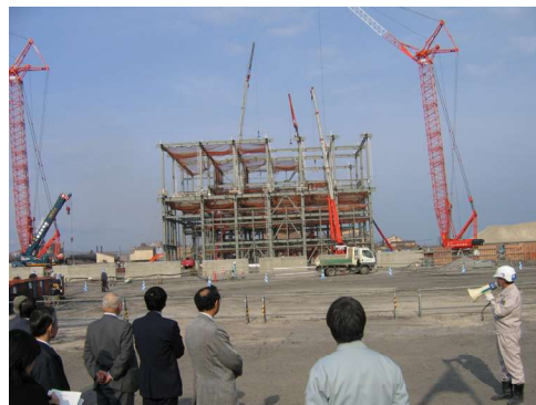
現場視察（PCB処理施設建設中：室蘭市仲町）
