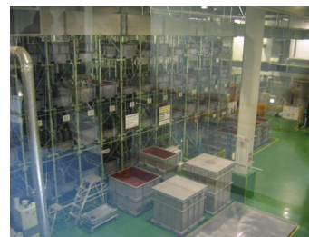
豊田事業（受入保管設備）
