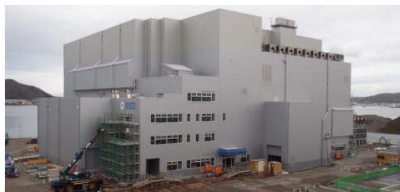
建設中の増設処理施設 (平成 24 年 11 月撮影)
