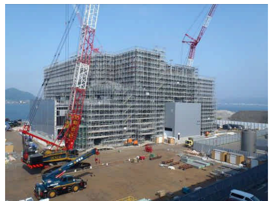
工事状況（H24.6撮影）
