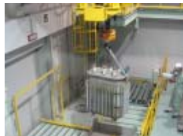
搬入されたPCB廃棄物
