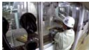
PCB廃棄物の解体作業
