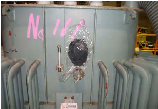
金属補修剤による油面計部の補修状況
