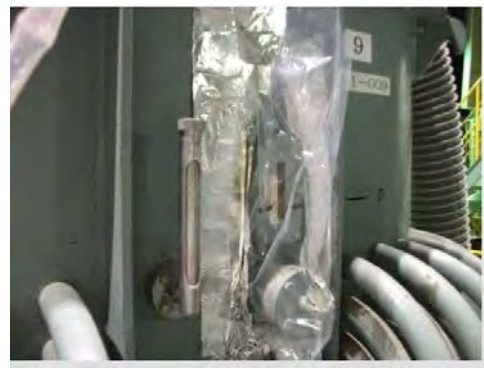
油面計の養生状況
