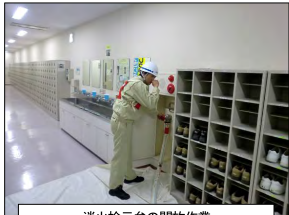
消火栓元弁の開放作業
