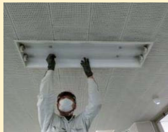
蛍光灯の反射板の取り外し
