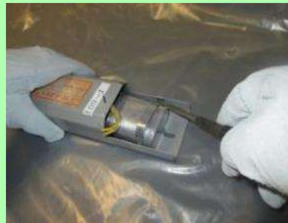
コンデンサの 取り外し作業
