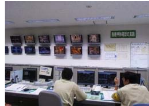
中制:ITVでタンクヤード火災を発見
