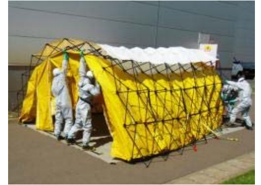
消防隊 除染テント 設営
