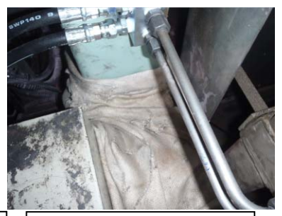
溶接作業時の養生(再現)
