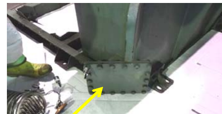
内部構造確認の為、サイドにあるハンドホールを解放
