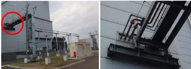
増設施設 鋼製カバー設置予定箇所
