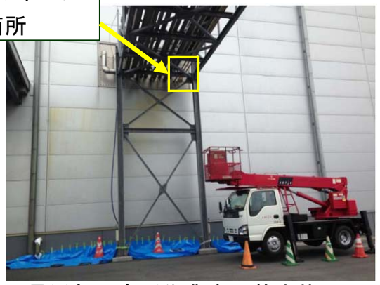
貫通部、高所作業車、養生状況
