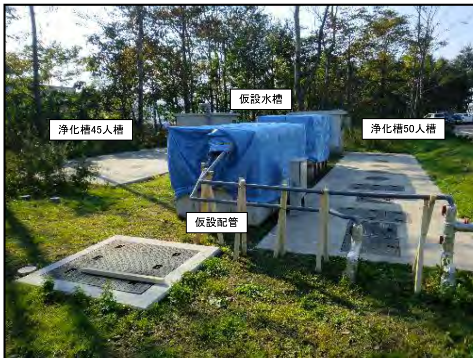
浄化槽及び仮設配管等の設置状況
