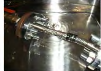
液中でホース内に空気を供給し漏洩部位特定
