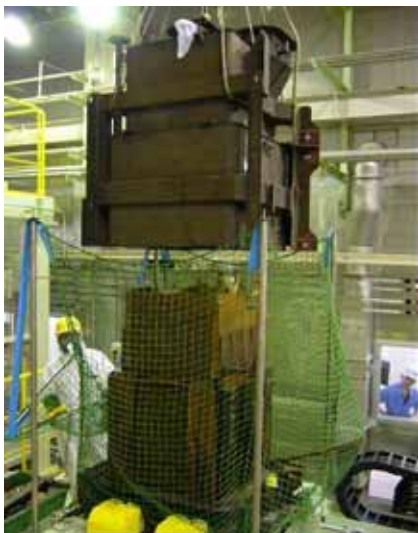
内部部材の取り出しの様子
