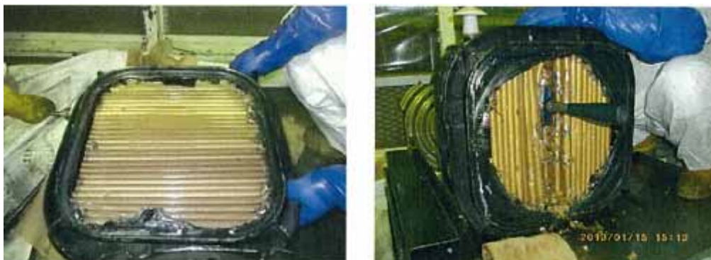
手解体の様子
