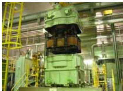
大型トランス・車載型トランスの解体工程 (遮蔽フード内作業)
