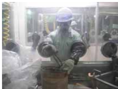
小型トランスの解体工程 (グローブボックス内作業)
