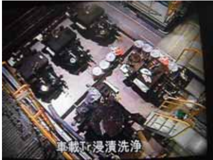
車載型トランスの予備洗浄工程
