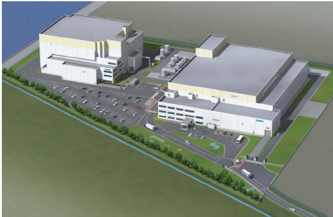
日本環境安全事業株式会社 平成24年3月
