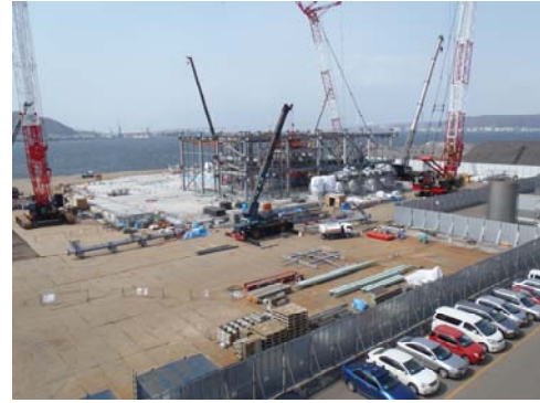
(鉄骨建方工事)
