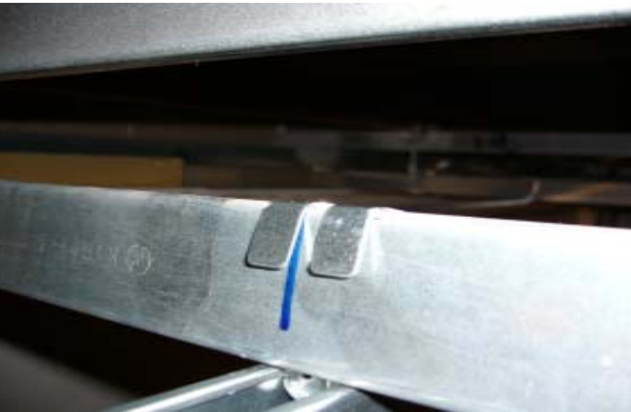
クリップでの野縁受けへの固定
