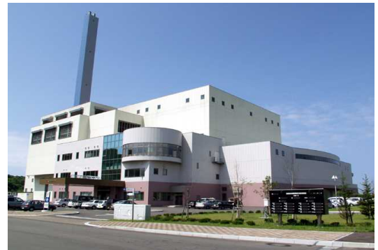
現焼却施設(メルトタワー21)
