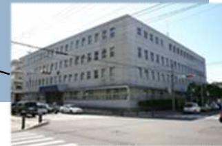
①市役所本庁舎（築68年）
