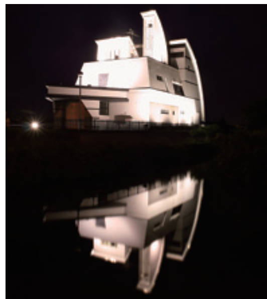
★本輪西汚水中継ポンプ場 (本輪西町国道沿い) 室蘭にゆかりのある「プロビデンス号」をイメージした外観が夜にひときわ白く明るく輝き、貯水池にも美しい姿を映し出します。ライトアップにかかる電気代は、本輪西港北地区活性化促進会が負担し、プロビデンス号のPRに一役買っています。
