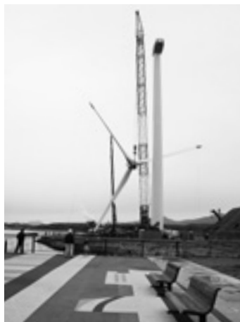
風力発電用風車の設置（10月31日）
