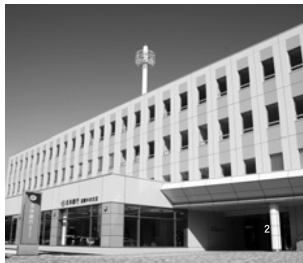
むろらん広域センタービル完成（2月28日）
