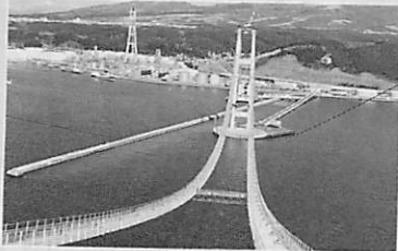
幅3.5mの空中足場が2本かけられる
