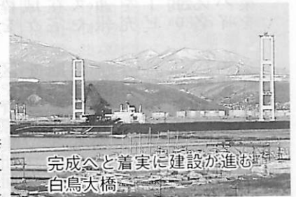
完成と着実に建設が進む白鳥大橋
