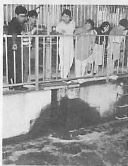
深さ5.5mのエアレーションタンクの中で微生物が活躍
