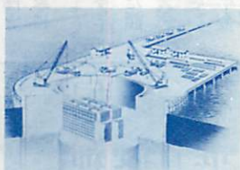
⑤下から隔壁コンクリートを構築
