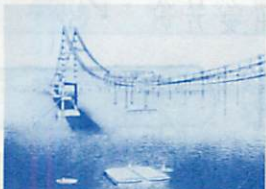
⑭海上から桁をつり上げ、ハンガーロープに定着する
