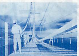
⑪索線127本束ねたストランドを1束ずつ架設
