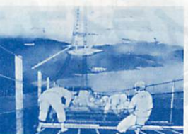
⑩ケーブルを架けるための足場をつくる
