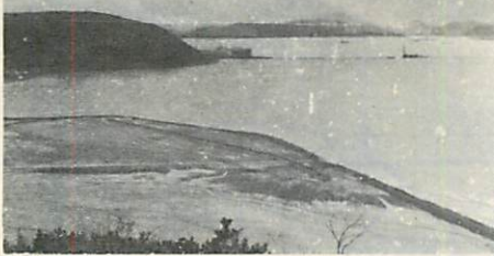
陣屋工業団地の造成
