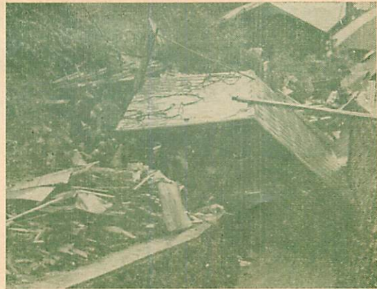
昭和37年の9・10号台風で家屋が全壊し、犠牲者がでた輪西地区の現場。
